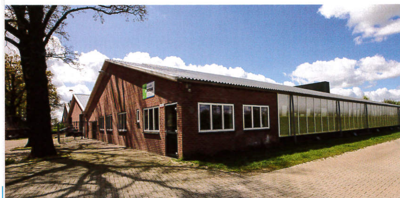
Der letzte Wachstumsschritt des Betriebes Rotink liegt vier Jahre zurück. In diesem Zuge wurde die Sauenherde verdoppelt.
